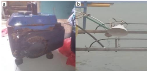
Gambar 5. Genset (a) dan lampu (b) milik nelayan nikel Gorontalo
